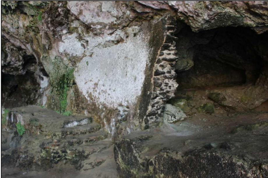
Figura 14. Grotta B, parte esterna. Il podio, in *opus reticulatum* con la scala e il muro rivestito di tartari (foto MDF).
