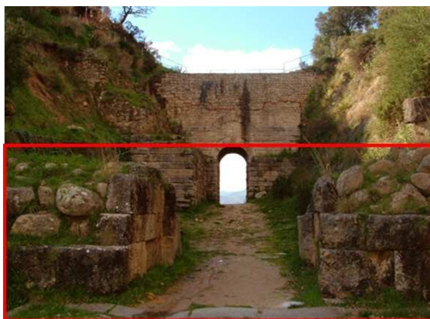
Figura3. In primo piano, contornato da un rettangolo rosso, vediamo i resti di Porta Arcaica. Sul fondo le strutture dell'arco a tutto sesto di Porta Rosa (fonte: www.agriturismoaurella.it/cilentoportarosa ).
