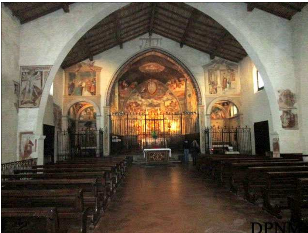
Interno della chiesa, ad aula unica, a pianta rettangolare non perfettamente regolare e tre Cappelle che formano la parte absidale.
