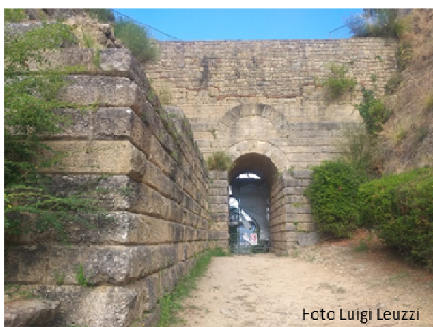
Figura 20. Angolo del muro di contenimento.
